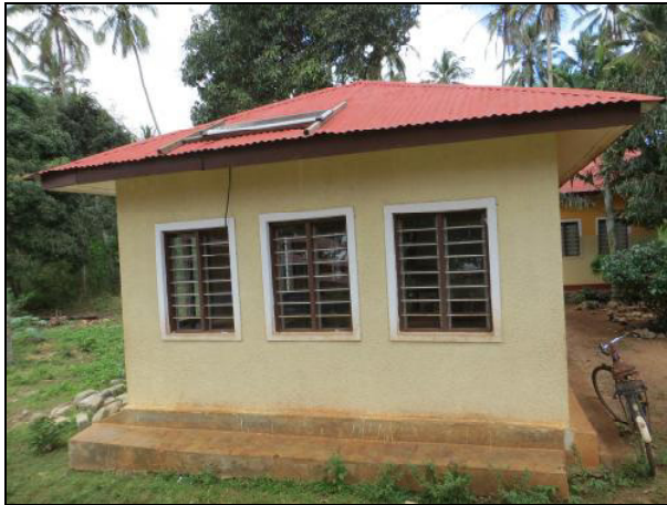
Computerraum mit Solaranlage
